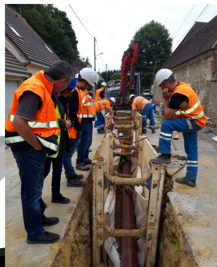
Pose de la canalisation rue de l'Église
