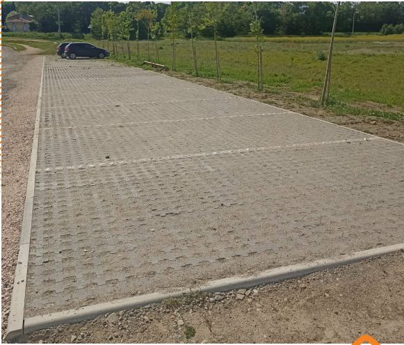
AMÉNAGEMENT DES PARKINGS DE LA ZONE DE LOISIRS AVEC DES PAVÉS DRAINANTS EN BÉTON.
