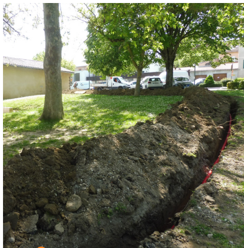
TRANCHÉES POUR LA POSE DE COFFRETS ÉLECTRIQUES PLACE OCCITANE.
