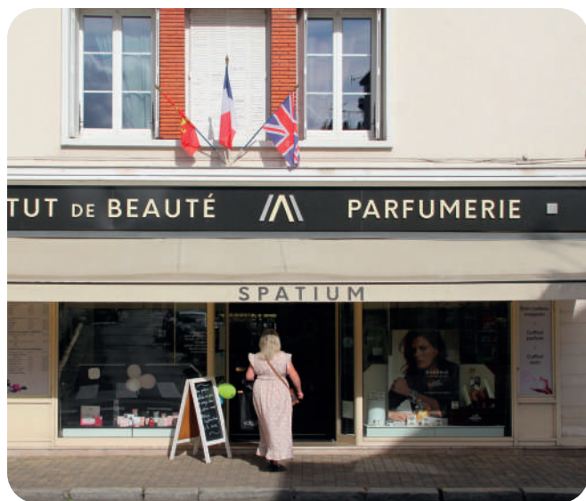
Grand store avec une enseigne placée sur le lambrequin
