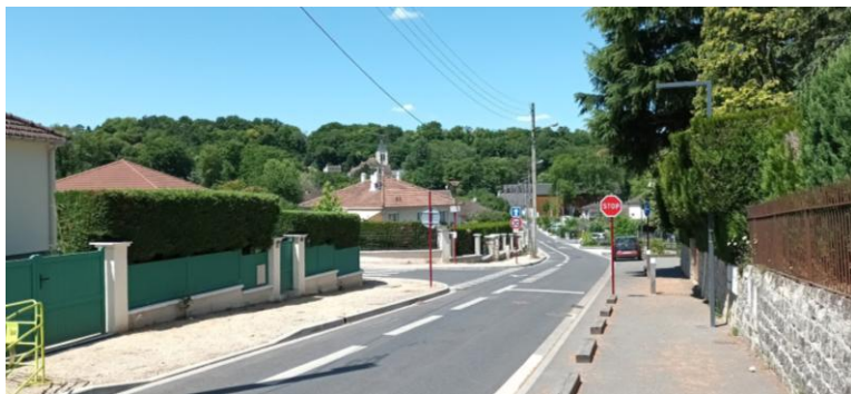
Rue de la république (Ingespaces)
