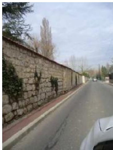
Clôtures le long d'une voie Rue Pierre Brossolette (Google)
