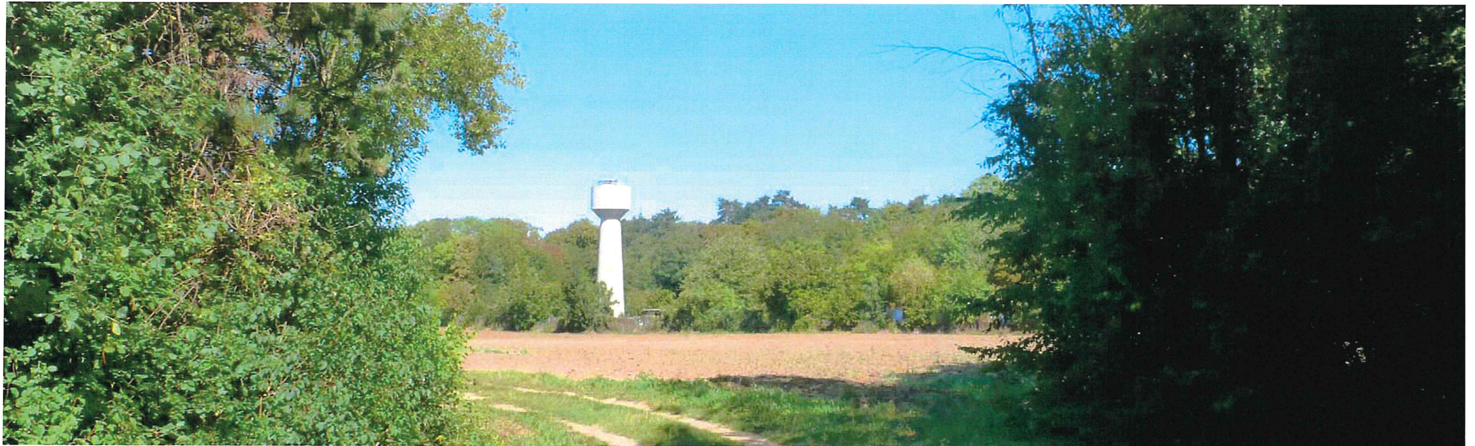
Le château d'eau : élément repère du plateau agricole
