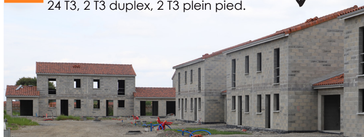
Avril 2026 : état d'avancement des travaux.
