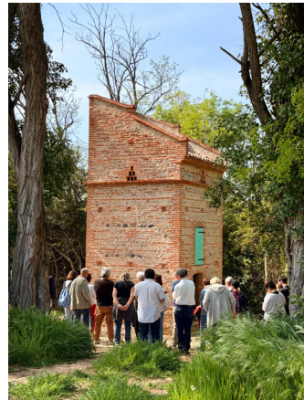
Rénovation du pigeonnier sur le chemin de Dominique
