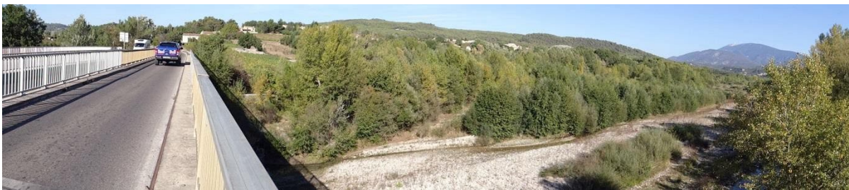
Traversée marquante de l'Ouvèze par le pont de la RD 938 avec vue panoramique
