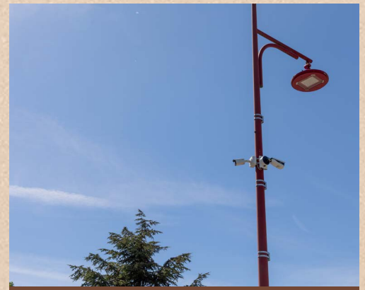
Installation de la vidéoprotection au CSCS rue des Stades
