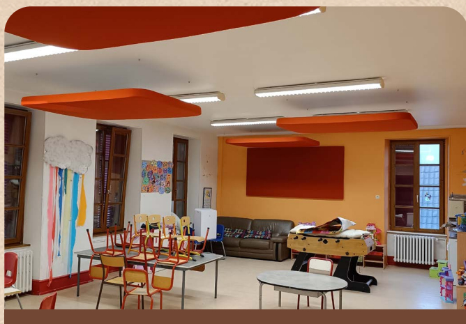
Installation de panneaux acoustiques au périscolaire à l'école élémentaire
