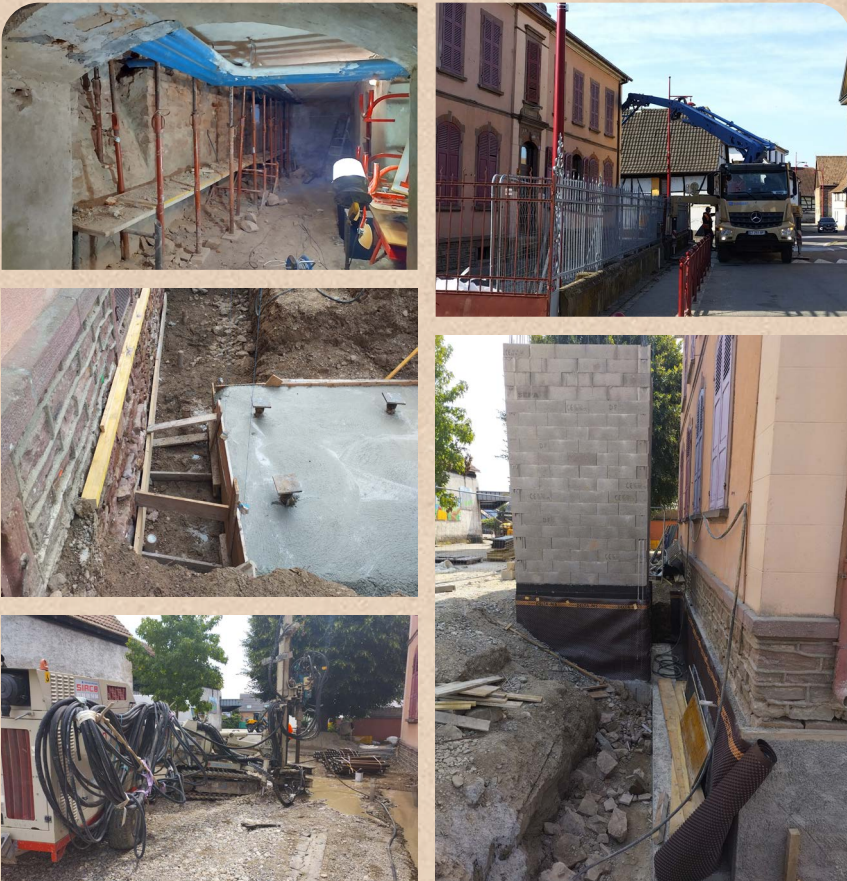
De grands travaux entrepris à l'école élémentaire
