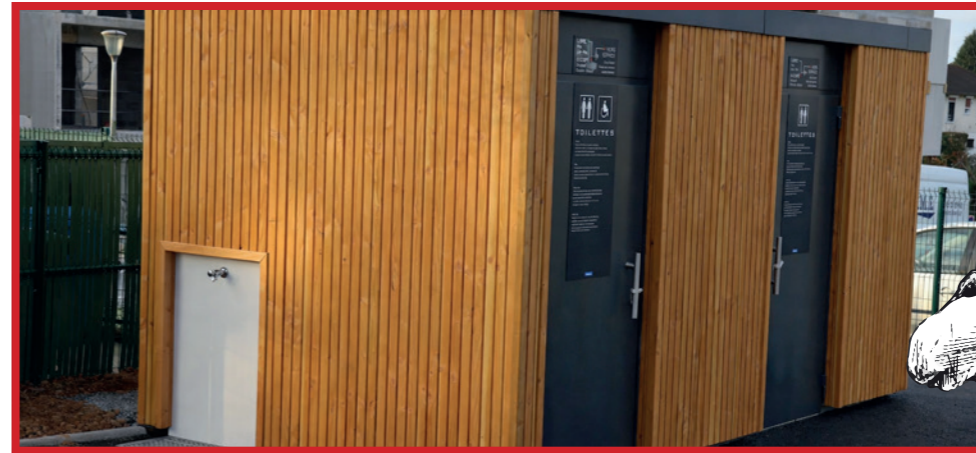
Installation de toilettes publiques au complexe sportif Pierre de COUBERTIN
