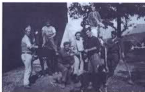
Soldats du 625 ème régiment de Pionniers construisant les blockhaus de Charvonnex hiver 39-40 (photo prise à Lécy)
