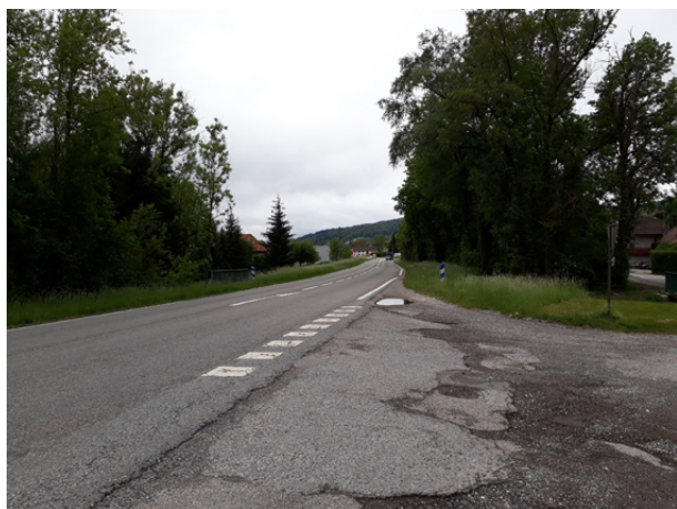
La RD1203 à l'entrée nord de Charvonnex
