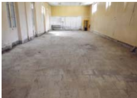
Salle Balzac avant travaux
