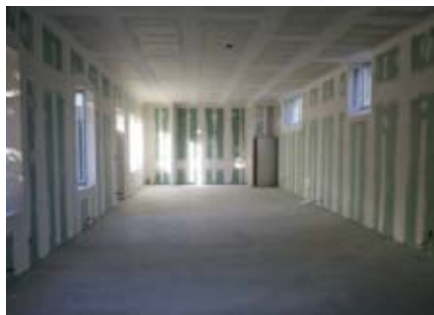
Salle Balzac en cours de travaux
