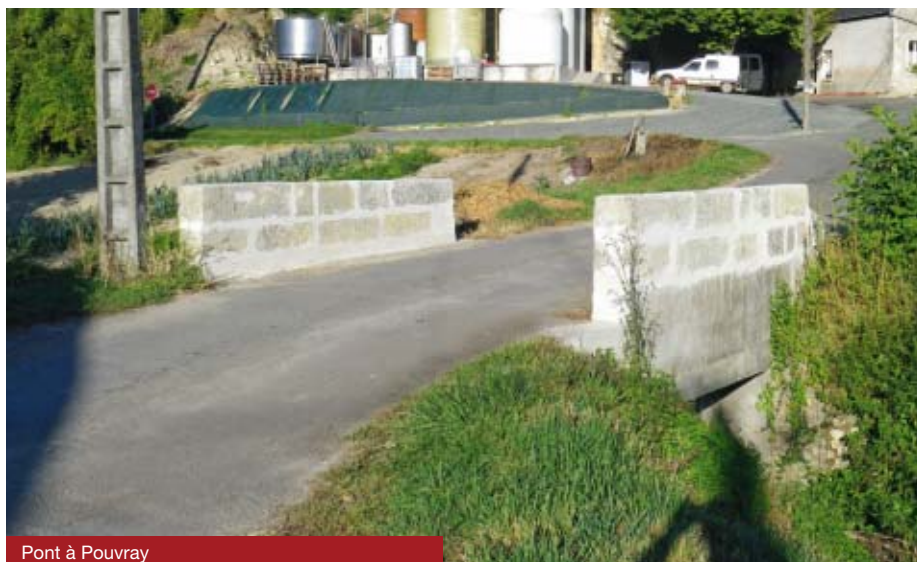
Pont à Pouvray
