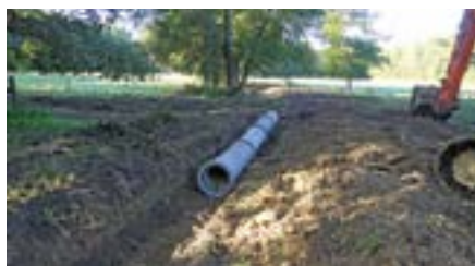
Pose de la buse d'alimentation de la zone tampon
