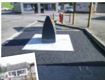
Installation par la CCTEV d'une colonne enterrée - Parking St Vincent
