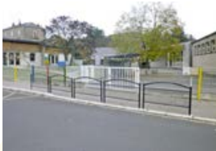
Mise en place de barrières devant l'école
