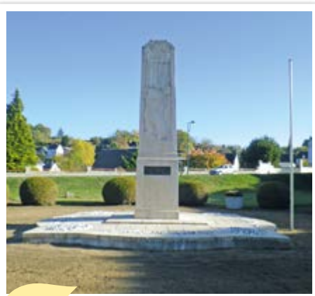
Réfection du Monument aux Morts avec aménagement des abords
