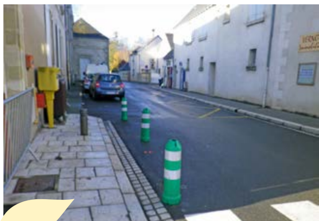
Rue Victor Hugo Installation de bornes
