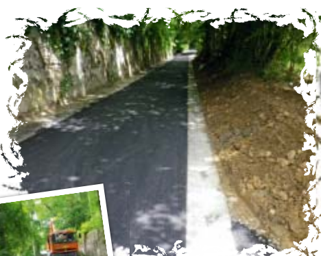
Travaux de réfection de la rue de la Mignonerie : 80 614 €
