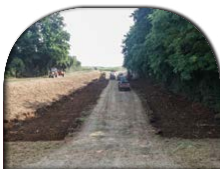
Travaux retenue d'eau - rue Neuve
