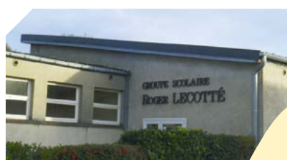
Rénovation de la couverture du préau de l'école primaire R. Lecotté : 19 570 €
