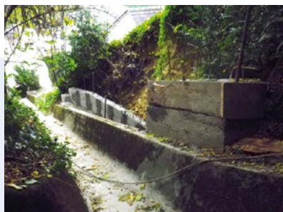
Comblement et réalisation d'une dalle béton pour renforcement du caniveau d'évacuation du Coteau Poupine : 9 036 €
