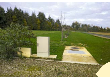
Participation aux travaux d'assainissement zone de Foujoin réalisés par la CCV : 58 770 €
