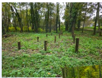
Réalisation en cours d'un parcours de santé : 6 100 €
