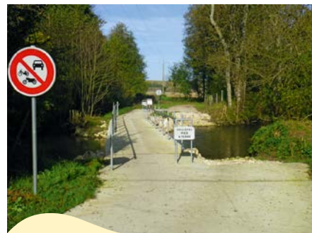
Voie Verte réalisée par la CCV
