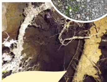
Comblement d'une cavité au Sentier de la Thierrière : 7 520 €
