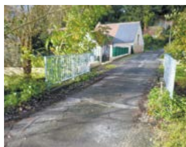
Gardes corps des Ponts rue des petites Barreries et le Cassereau
