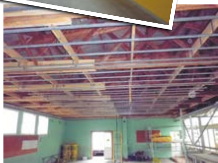
Travaux réfection préau de l'Ecole primaire du bourg
