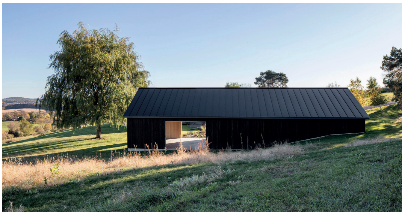
Stockage matériel de jardinage
