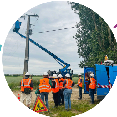
3 JUIN VISITE DU CHANTIER ENEDIS DE RÉNOVATION PROGRAMMÉE À OXELAÏRE ET HONDEGHEM
