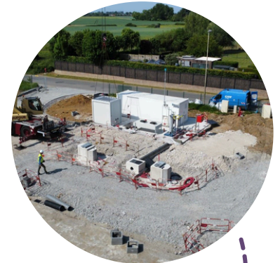
JUIN TRAVAUX DE LA STATION GNV DE WORMHOUT
