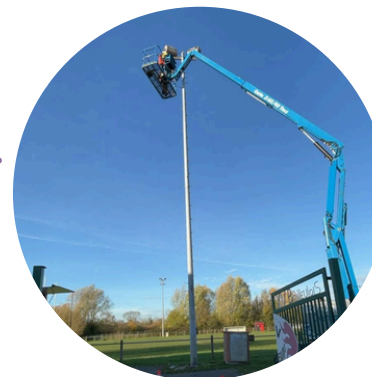
12 NOVEMBRE COMMENCEMENT DES TRAVAUX DE MODERNISATION DE L'ÉCLAIRAGE AU STADE DE RUGBY DE BAILLEUL
