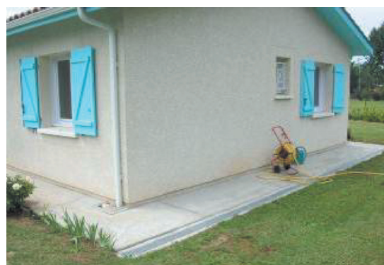
Figure 20 Large trottoir avec caniveau de collecte des eaux de ruissellement (Source Socabat)
