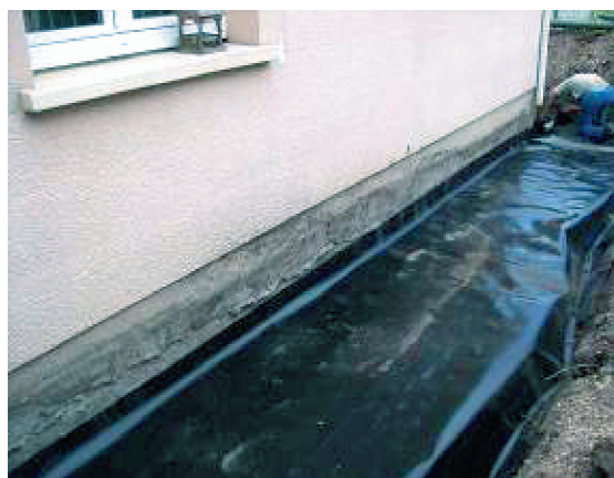
Figure 22 Géomembrane en cours de pose (Source Socabat)
