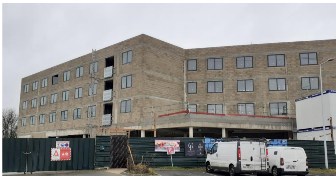
Figure 11 : Travaux de l'hôtel
