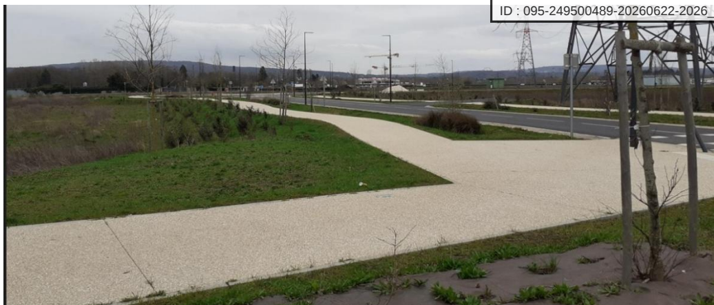
Figure 3 : Aménagement des trottoirs
