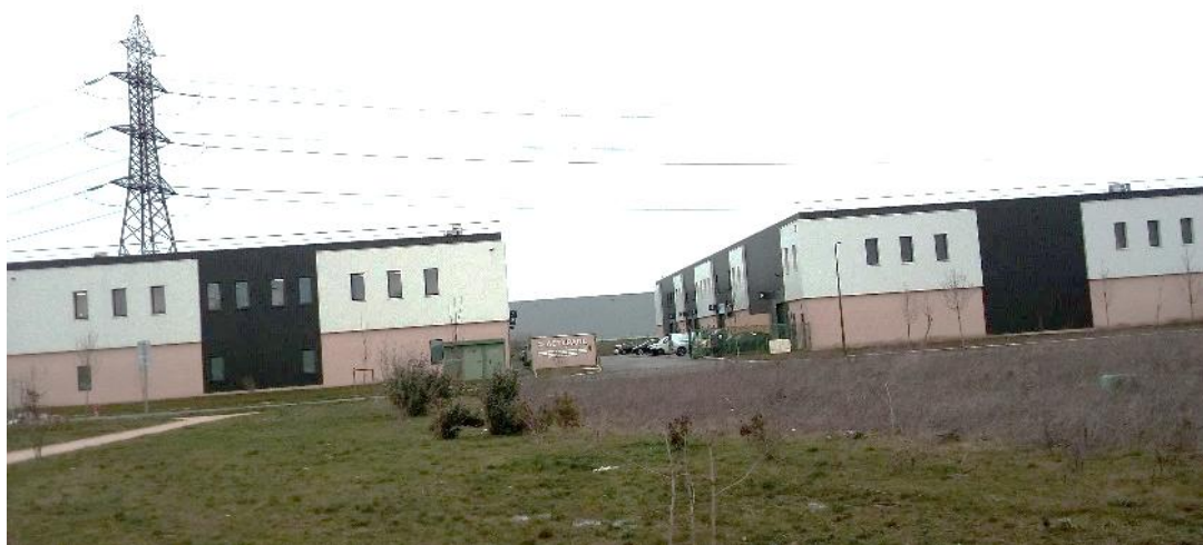
Figure 15 : ACTIPARC- Lot 9.1 et 9.2-- Bâtiment A et B-
