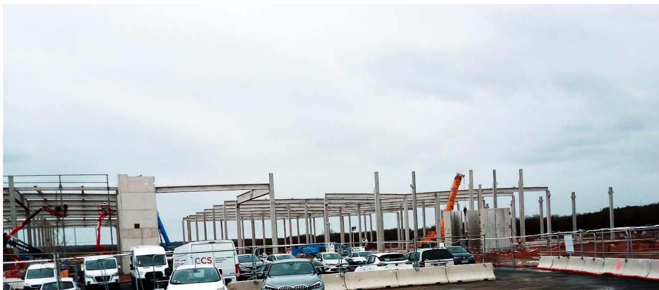
Figure 12 : Travaux du bâtiment logistique
