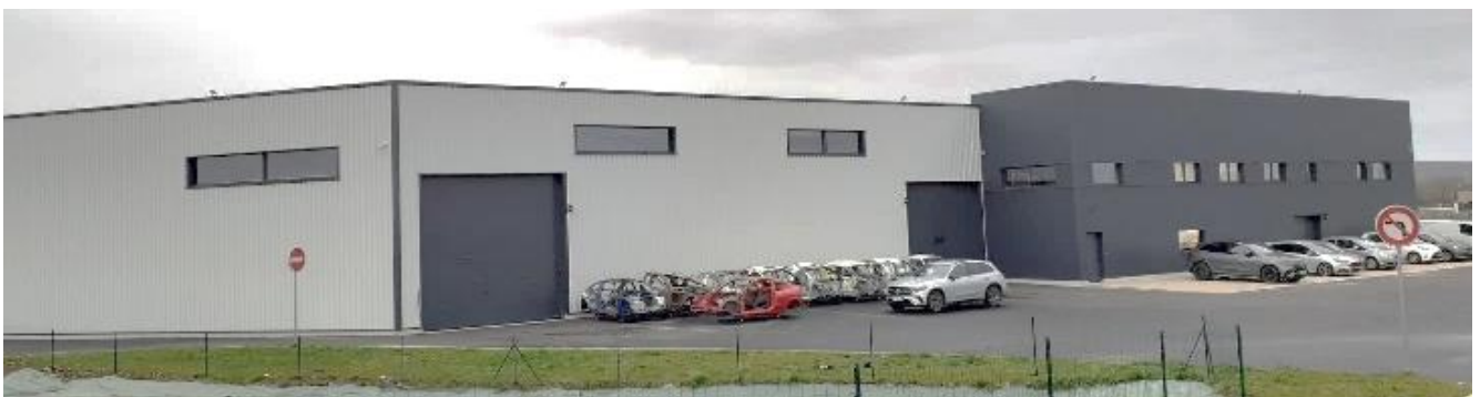
Figure 17 : SAS MATTER France- en exploitation
