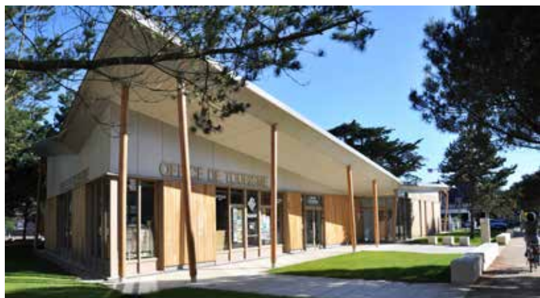
Le nouvel Office de tourisme de Fréhel-Sables-d'Or-les-Pins : une volumétrie très aérienne, parfaitement intégrée dans la pinède.
