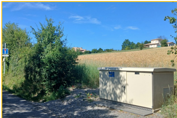
Route de La Basse-Rue. Installation d'un transformateur.
