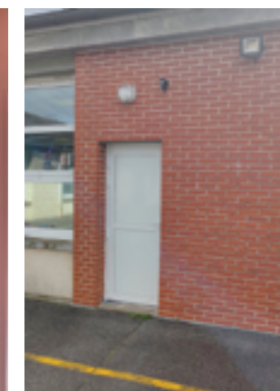
Réparation de la porte de l'école
