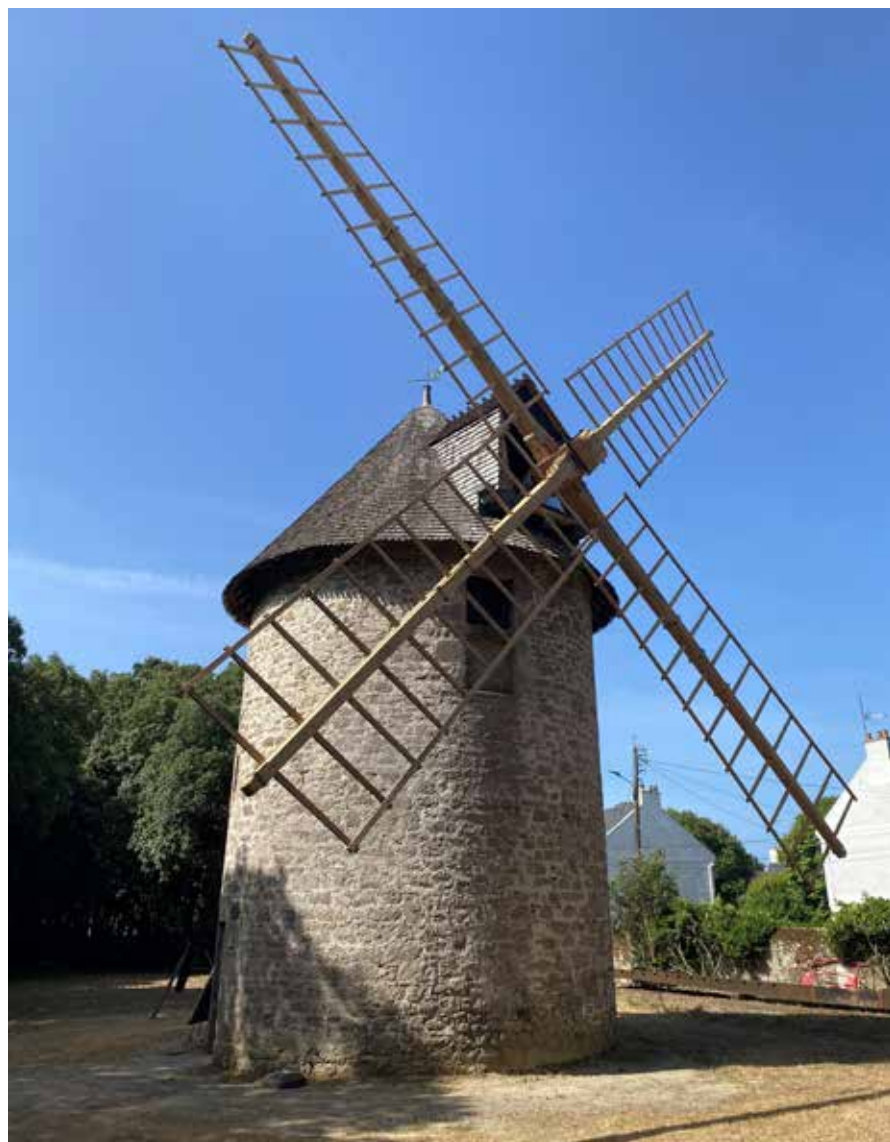
Les nouvelles ailes du moulin en place
