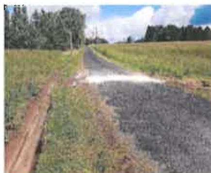
Mariot Réparation traversée route fossés
