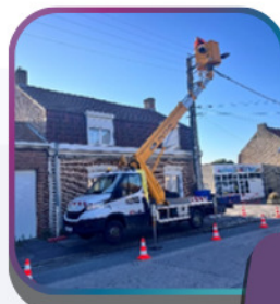
Nieppe Chantier Article 8 21 août 2024
