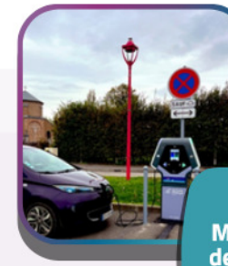
Nieppe Mise en service de 2 bornes IRVE 17 octobre 2024
