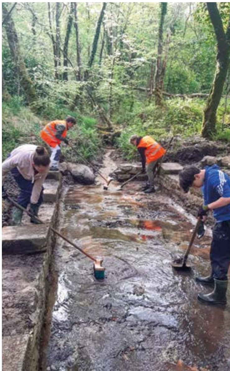
Nettoyage du lavoir de Stang er Vénage
