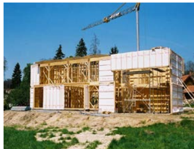
Chantier d'une maison à ossature bois
