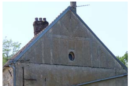
Pignon enduit avec oculus et faux appareil de pans de bois.
