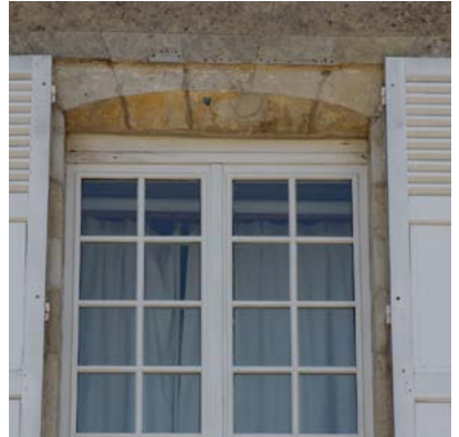
Platebande appareillée avec légère voussure sur un linteau de fenêtre d'une maison de maître.
