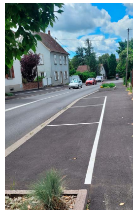
Trottoirs rue du 23 novembre
