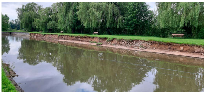
Travaux de réfection aux étangs
