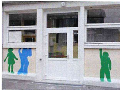
Remplacement de la porte de la Maternelle.
