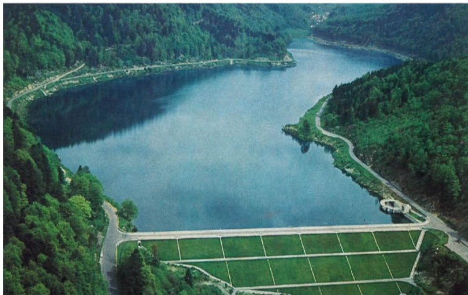
Le barrage de Kruth-Wildenstein a été construit dans les années soixante pour tempérer le caractère impétueux de la Thur. Photo fournie
