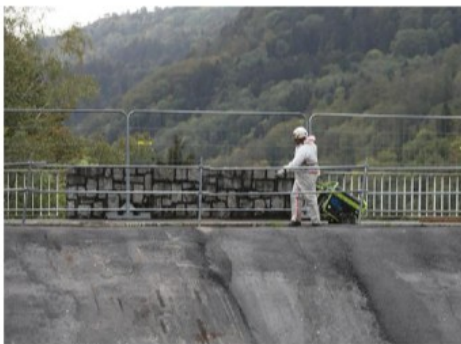
Travaux d'aménagement et de renforcement au barrage de Kruth-Wildenstein en 2020. Le lac avait été asséché le temps des opérations. Photo archives Vincent Voegtlin
