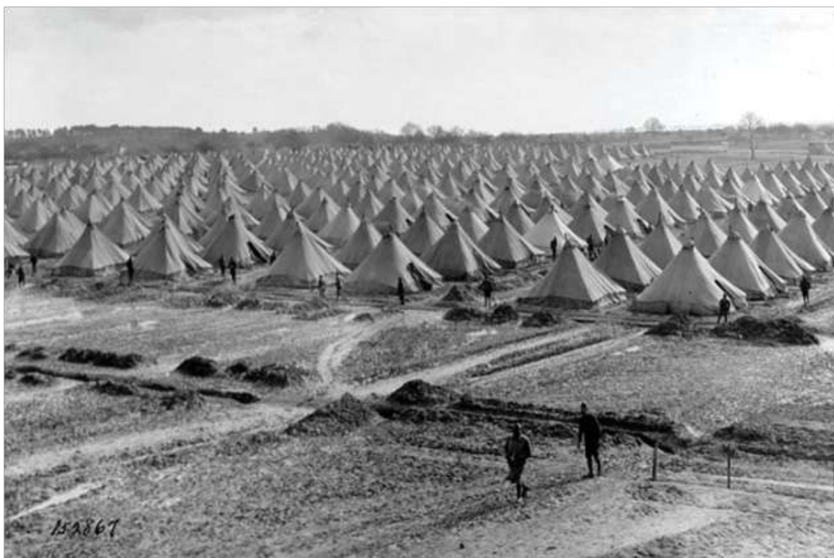
Figure 3 : Vue générale du camp de Noyers-sur-Cher. 3
