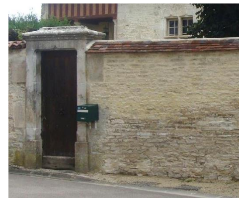
- 2 - Mur en pierre avec joints affleurant et chaperon en tuile plate
