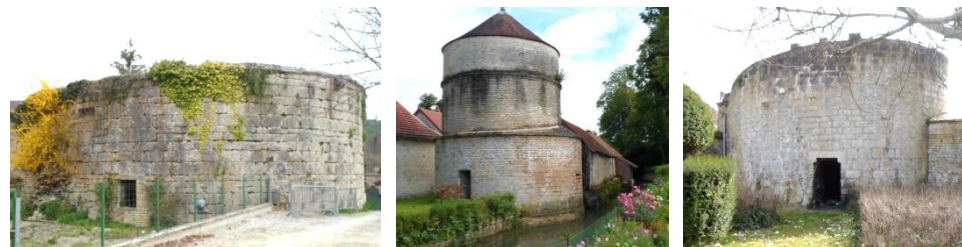
Les vestiges des tours de fortifications de l'enceinte
