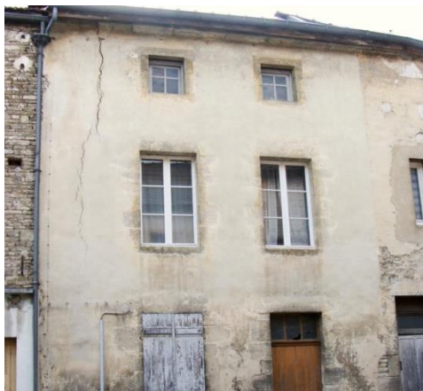
Enduit à la chaux, posé à fleur des pierres d'encadrement de baies et des chaînages
