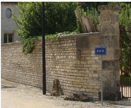
- 3 - Mur en pierre protégé par un couronnement en pierre de taille.
