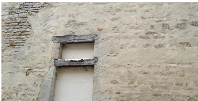
Enduit «à pierre vue» recouvrant les irrégularités de la pierre
