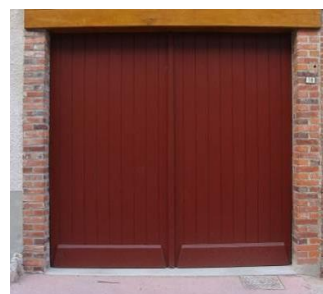
Porte de garage avec habillage de planches de bois assemblées
