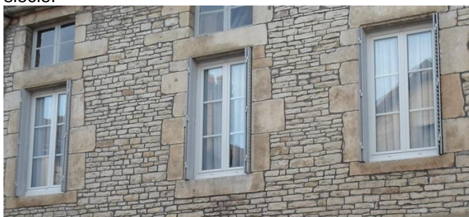
Joints au ciment gris interdits
