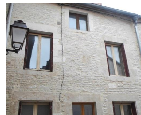
(2) Maçonnerie avec joint affleurant la pierre
