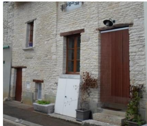
Linteaux en bois pour les habitations modestes et les bâtiments agricoles
