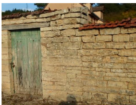
- 5 - Mur en pierres sèches protégé par un couronnement en tuile mécanique.
