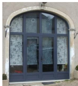
Porte charretière fermée par un ensemble menuisé en alu vitré
