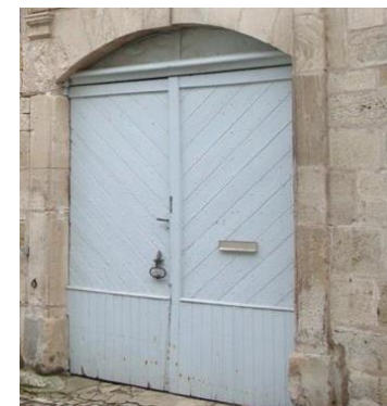
Intégration préconisée d'une fente de boîte aux lettres dans des portes en bois
