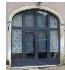
Porte charretière fermée par un ensemble menuisé en alu vitré
