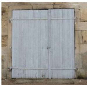
Porte de garage en planches de bois assemblées
