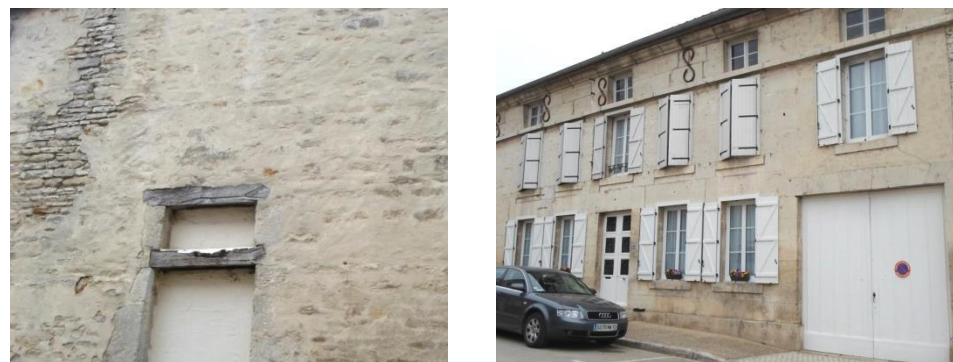
Enduits à « pierre vue »
