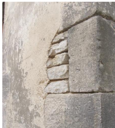
Enduit à la chaux, posé à fleur des pierres d'encadrement de baies et des chaînages
