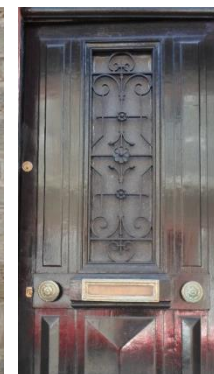
Intégration préconisée d'une fente de boîte aux lettres dans des portes en bois
