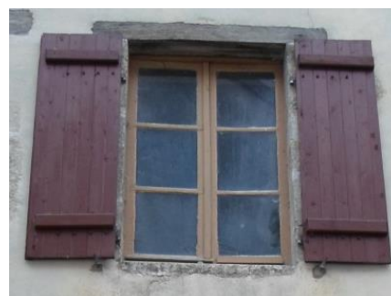
Volets pleins en bois assemblés sur barres
