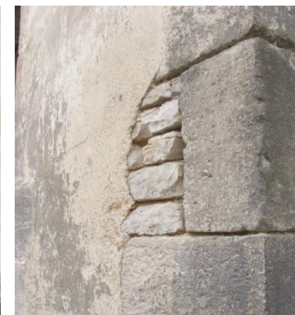
Enduit taloché au même nu que les encadrements de pierre de taille (sans surépaisseur)
