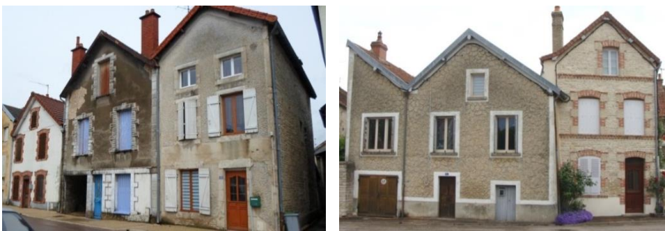
Ensemble de maisons dont les encadrements et les enduits de façade ont été remaniés
