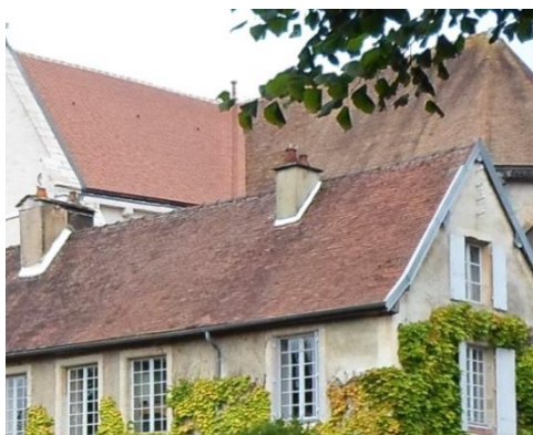
Toiture en petites tuiles plates
