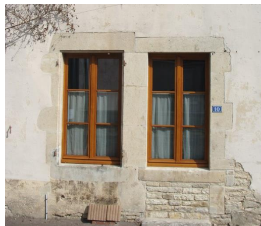
Enduit taloché au même nu que les encadrements de pierre de taille (sans surépaisseur)
