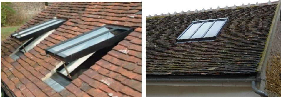
Exemples de châssis de toit métallique de type patrimoine avec un meneau central assimilé aux anciennes tabatières et verrière de toit.
