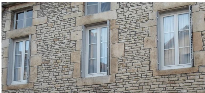
Joints au ciment gris interdits
