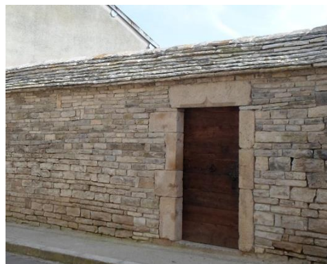
- 4 - Mur en pierres sèches protégé par un couronnement en pierre de lave
