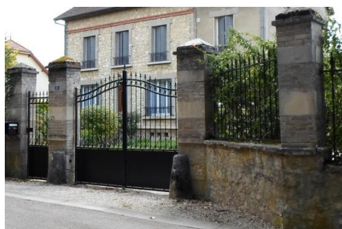
- 6 - Mur bahut surmonté d'une grille en ferronnerie
