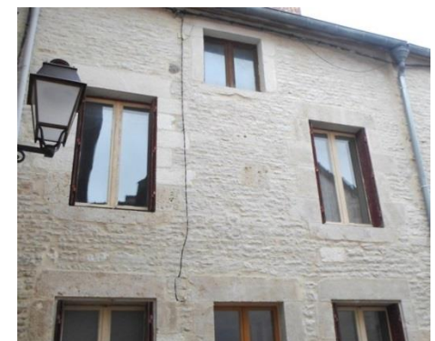
(2) Maçonnerie avec joint affleurant la pierre
