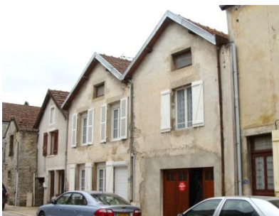
Succession de façades à pignon, rue Gambetta
