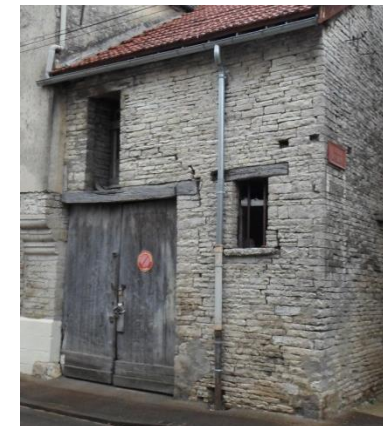
Linteaux en bois pour les habitations modestes et les bâtiments agricoles
