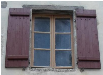
Volets pleins en bois assemblés sur barres
