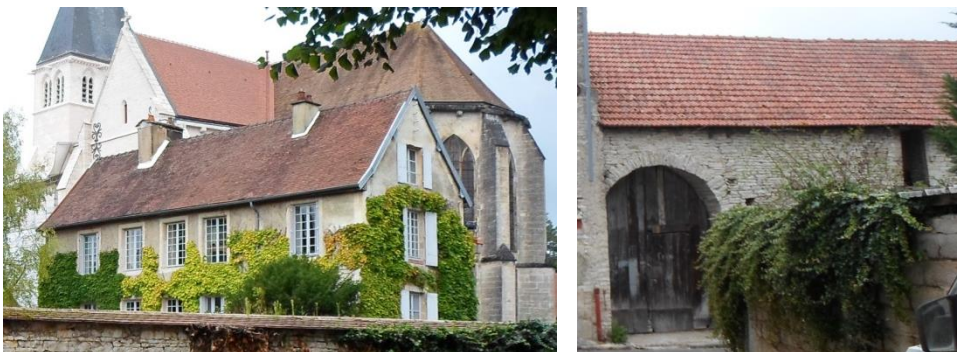
Couverture en petite tuile plate sur l'ancien presbytère – tuile mécanique
