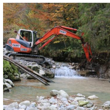
Démolition du Barrage de coiserette ©PNRHJ
