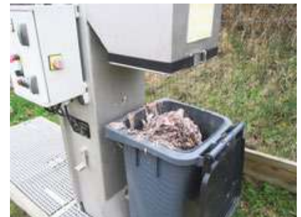
Récupération des déchets à l'entrée d'une station de traitement des eaux usées
