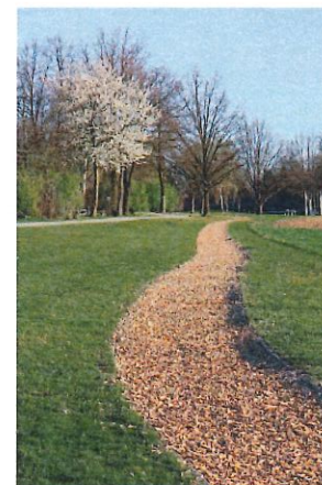
> CHEMINEMENT SECONDAIRE EN COPEAUX
