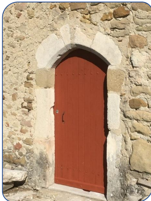
Portes restaurées et réinstallées
