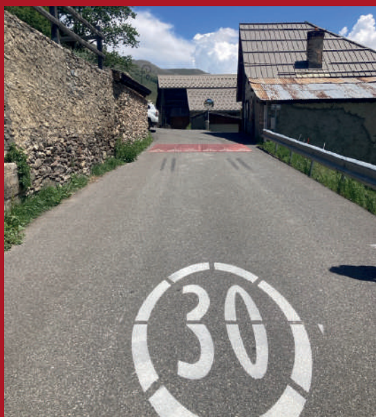
Aménagements en faveur de la sécurité routière
