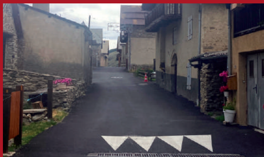
Fin des travaux à Fontgillarde
