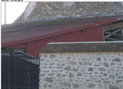
Toiture à deux pans
