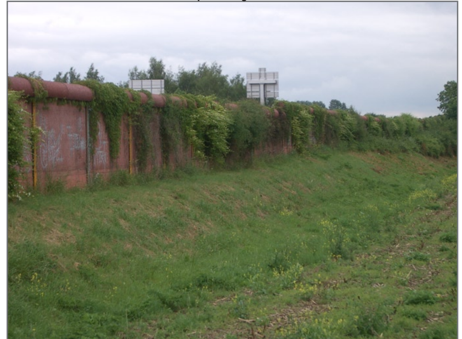
Présence d'un mur d'isolement acoustique le long de la RN4 : un rôle réflecteur
