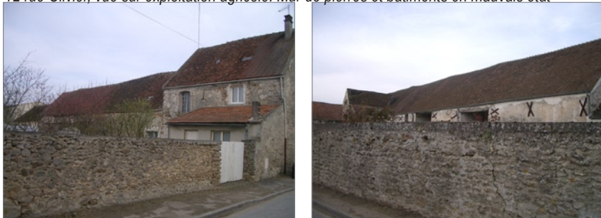
12, rue Olivier, linteau cintré et bâtiments agricoles
