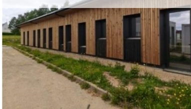
Des classe lumineuses côté entrée principale
