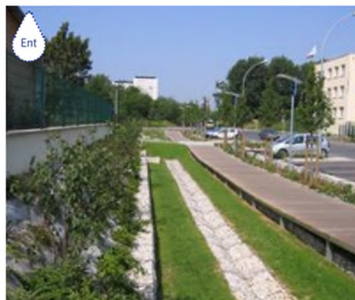
CLICHY-SOUS-BOIS (93) : PARC D'ACTIVITÉ - TRANCÉE DRAINANTE POUR LE RESSUYAGE DE LA NOUE.
