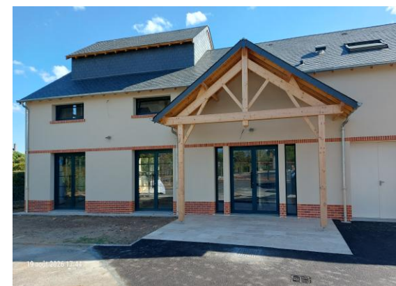
La nouvelle maison des associations
