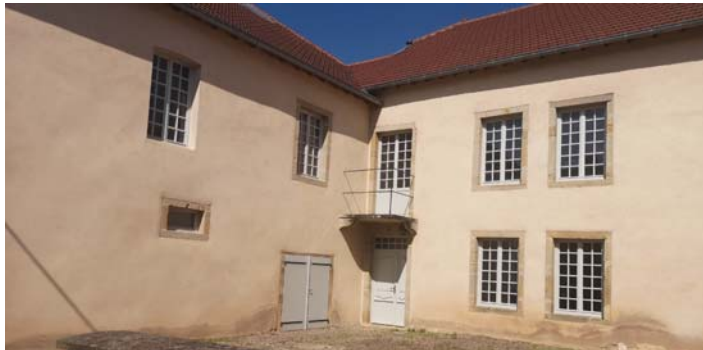
Le bâtiment de la future micro-crèche de Saulx
