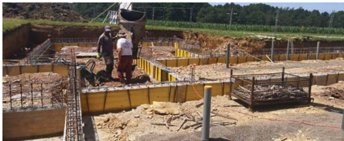
Le chantier a démarré à Citers
