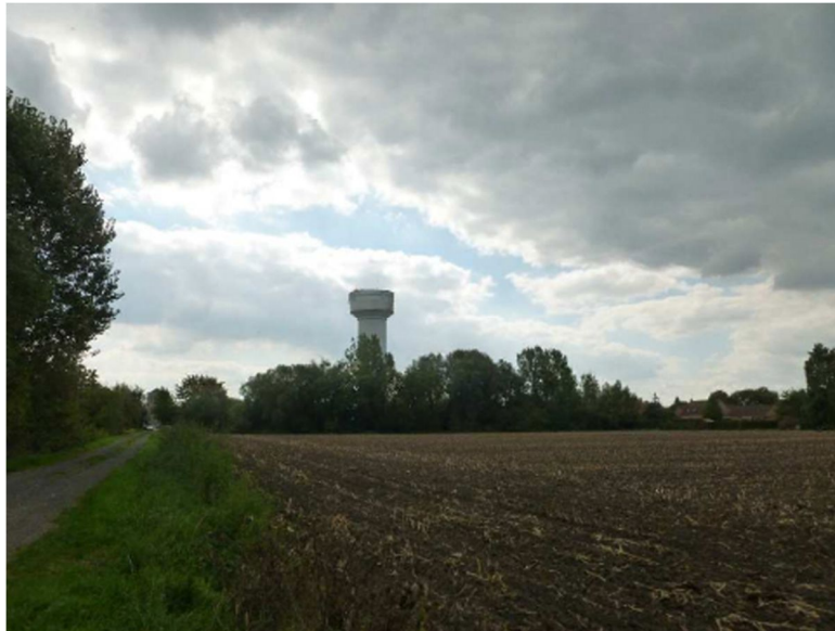
Vue du Site depuis le Nord au niveau du Chemin bordant la Parcelle
