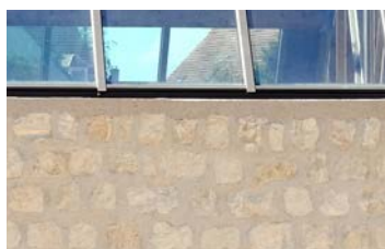
Moellons et vitrage
