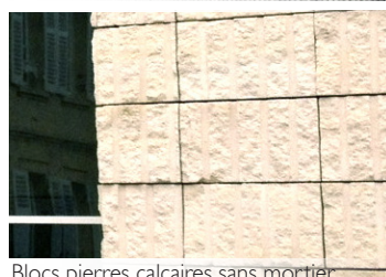
Blocs pierres calcaires sans mortier
