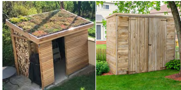
Bardage bois, simplicité du volume, pente de toiture simple, toiture végétale
