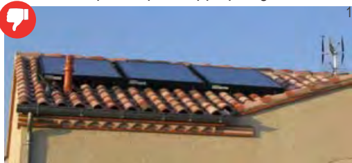
1. Capteurs solaires à Livers-Cazelles / A éviter : Pose en applique sur les tuiles
