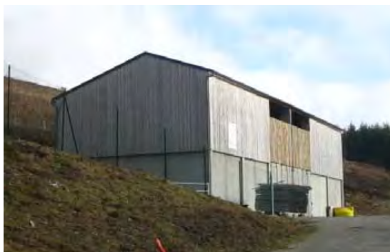
Hangar en bardage bois intégré dans la pente à Fraïsse-sur-Agoût
