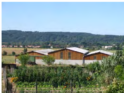
Hangars mitoyens en bardage bois à Serviès
