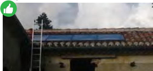
2. Capteurs solaires à Damiatte / A privilégier : dans le même plan que la couverture (en remplacement des tuiles)
