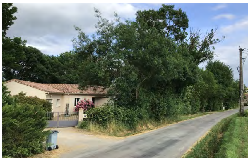
Haie comme limite du nouveau pavillonnaire
