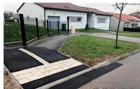
Des travaux de mises aux normes PMR des passages pour piétons ont été réalisés au lotissement de la Treiche et rue Ernest Sarloutte, où le chantier s'est traduit par un abaissé de trottoir et la matérialisation d'une bande de guidage et d'une bande podotactile.
