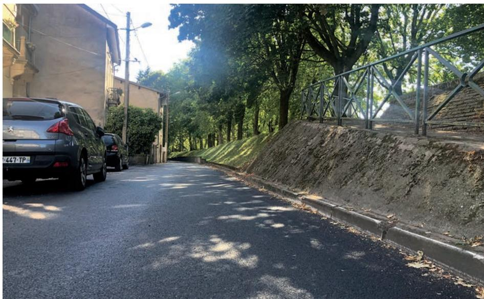
L'entretien des voiries appelle parfois des traitements différenciés. C'est le cas dans le boulevard De Riolle dont la chaussée a bénéficié d'une double intervention : ravalement suivi d'un renouvellement de la couche de roulement sur 670 m, là où la chaussée
